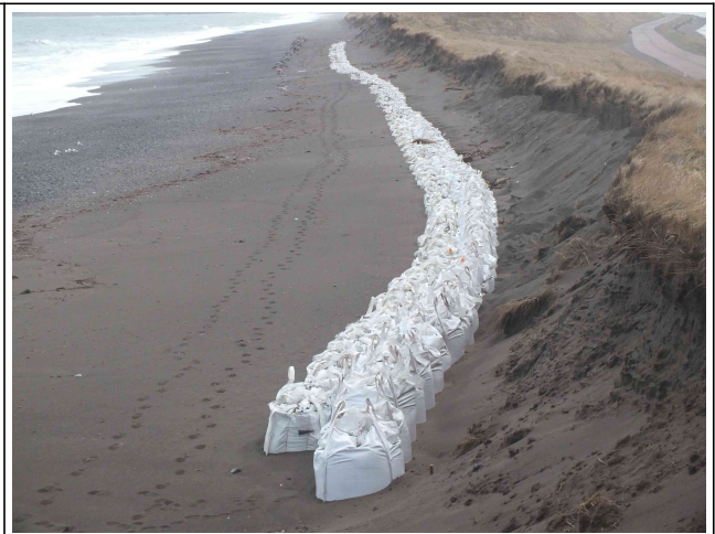
Rechargement de la plage sur les 2 cordons
